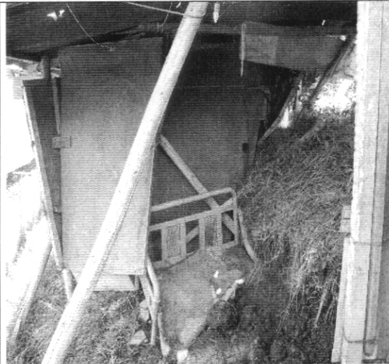
Foto 1. Vista lateral de las 2 viviendas afectadas en la que se presentó un flujo de tierra que comprometió 15 m 3 de suelo aproximadamente.
