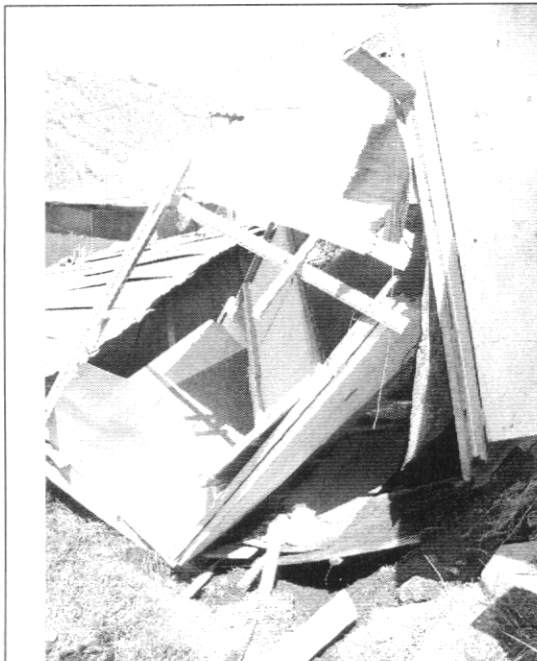
Foto 2. Colapso de la parte frontal de la vivienda de la Mz. 6 Lote 14 donde habita la familia de la señora Paula A Cárdenas, como consecuencia de un flujo de tierra con comportamiento retrogresivo.
