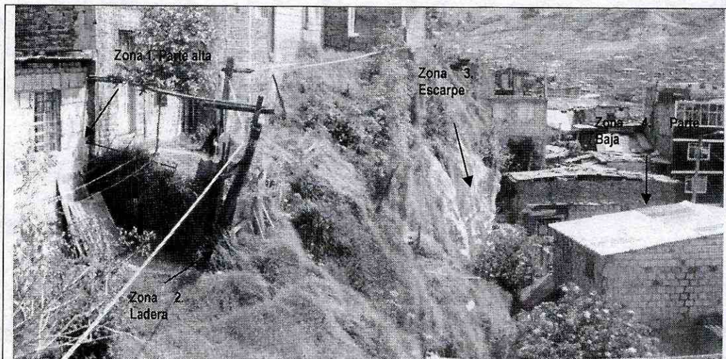
Fotografía 1. Vista general del sector. Se aprecia la parte alta (zona 1) y la parte baja (zona 4) en la que se emplazan las viviendas, la zona 2 correspondiente a la ladera empedrada de pendiente moderada a alta y la zona 3 del escarpe en roca arenisca producto de la antigua explotación minera.
