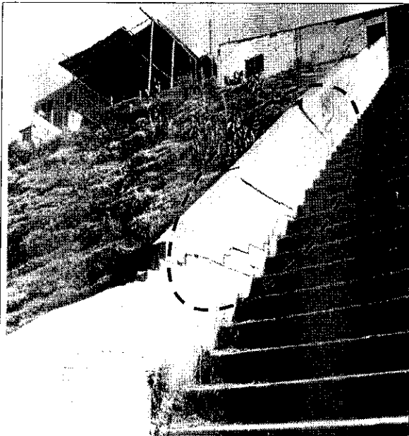
Foto 5. Daños observados en las escaleras del Parque de la Zona Verde No. 4, posiblemente asociados al Proceso de Reptación.
