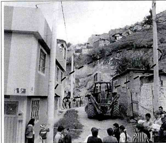
Foto 1. Zona donde se generó el deslizamiento. (Evento 65844)
