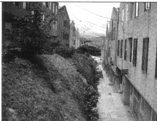
Foto 17. Estructura de los edificios sin evidencia de fallas estructurales.
