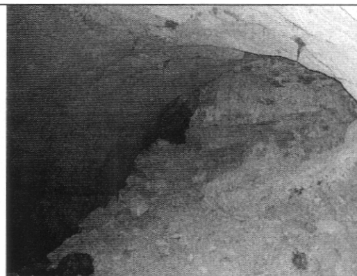
Foto 6. Zona final del frente de excavación abandonada.
