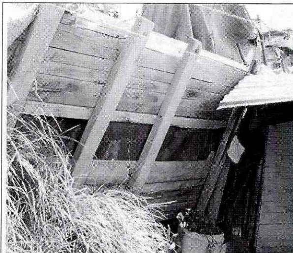
Foto 1. Perda de verticalidad en la entrada del predio 2 donde habita la Señora Emma Jerez.
