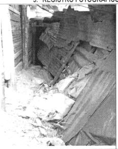
Foto 2. Se observa el empuje ejercido por el desplazamiento del material deslizado, en la parte oriental de I predio, lo que ocasiona la pérdida de verticalidad de la vivienda.
