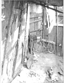
Foto 1. Se observa la pérdida de verticalidad de la vivienda debida al empuje del material deslizado en la parte posterior de la misma.
