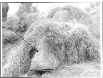
Fotografía 2. Detalle del bloque de roca potencialmente inestable. Nótese la ubicación en el talud en la Fotografía 1.
