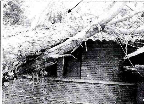
Foto 3. Árbol que recibió el árbol que colapsó e impidió que la cubierta se afectara en mayor magnitud.
