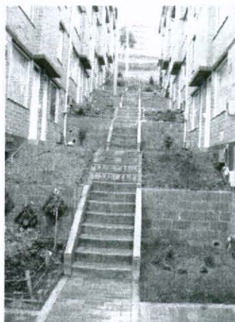
Fotografía No. 2. Aspecto general de las casas del Conjunto Portal de la Séptima.
