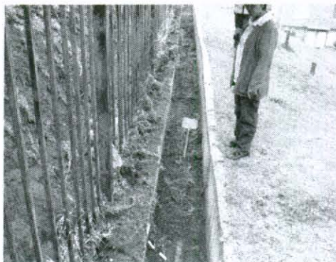
Fotografía No. 4. Vista general de la cuneta ubicada en la parte alta al oriente de Conjunto Portal de la Séptima.
