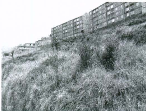
Fotografía No. 3. Aspecto general de la zona no urbanizada al oriente del Conjunto Portal de la Séptima.
