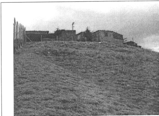
Fotografía 1 Ladera correspondiente al presente diagnóstico, talud empadizado con cespedón. A la derecha de la foto se encuentra el Parque Brisas del Volador, arriba se ubican las viviendas evaluadas.
