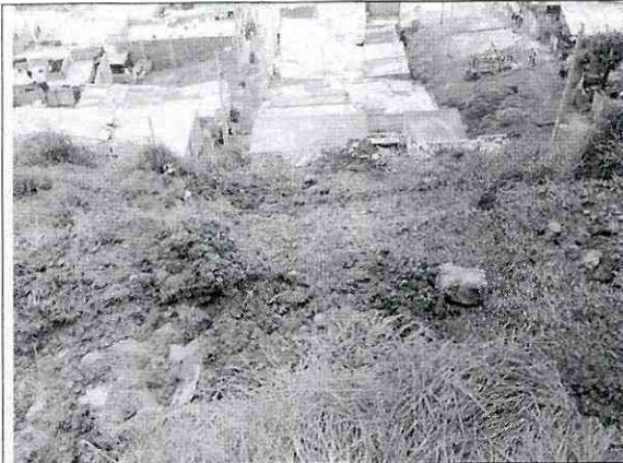
Fotografía 3. Se aprecian algunas de las viviendas que se recomienda permanezcan evacuadas hasta que se implementen las obras. (Tomada desde la corona del deslave)
