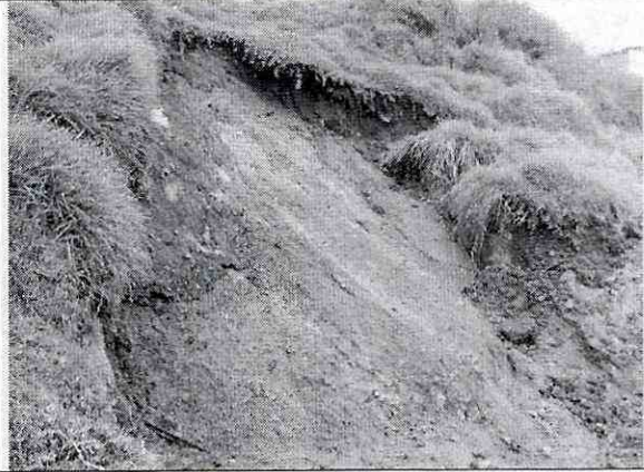
Fotografía 4. Corona del deslave donde se aprecia el espesor de la capa de materia orgánica y la superficie de falla.
