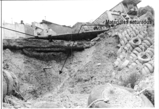
Foto 2. Se aprecia el grado de saturación de los materiales, con aguas provenientes de la red del acueducto comunitario del sector.
