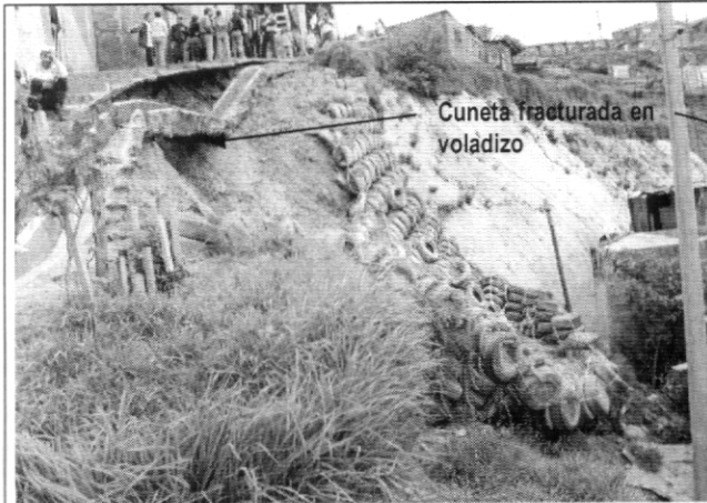
Foto 1. Sitio en el que se desarrolló el fenómeno de inestabilidad, se aprecian las afectaciones que presentaron las obras de mitigación que se adelantaron sobre el antiguo talud minero.
