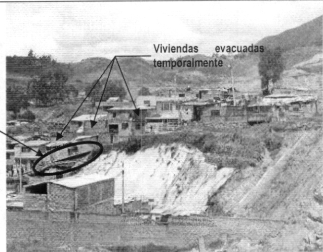
Foto 2. Se aprecia el grado de saturación de los materiales, con aguas provenientes de la red del acueducto comunitario del sector.
