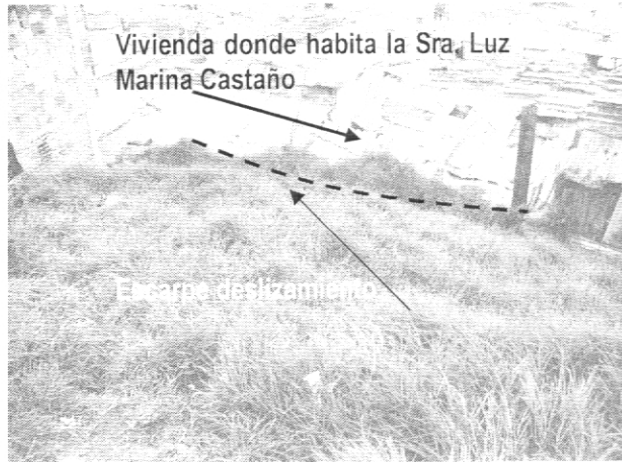
Fotografía 9. Parte Superior del talud de corte
