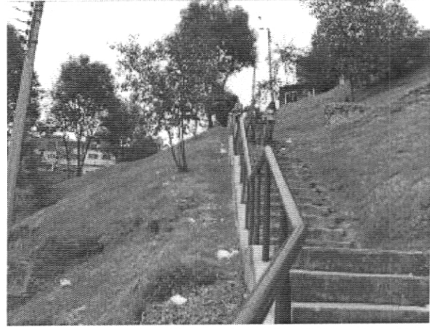
Fotografía 4. Inclinación del árbol junto a la zona de grieta y deslizamiento en estado incidente de actividad.
