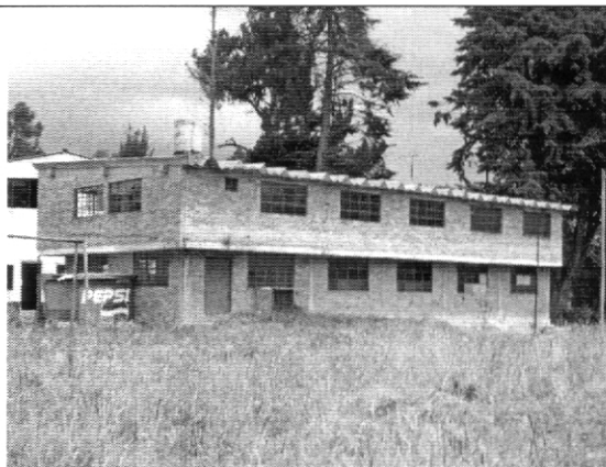
Foto 6. Bloque 6 Aulas de dos pisos (Tomada el 18/08/2006)
