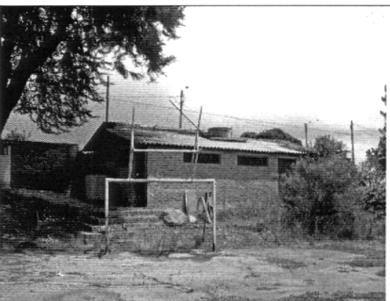
Foto 8. Bloque 8 Baños (Tomada el 18/08/2006)
