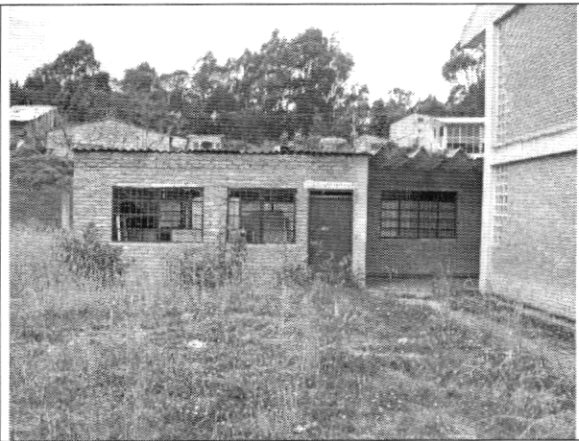
Foto 2. Bloque 2 Aulas del Costado Sur (Tomada el 18/08/2006)
