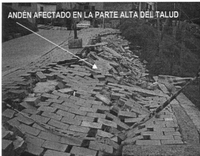
Fotografía 1 Andén afectado por la falla del talud en la parte alta de la vivienda del Sr. Eduardo Rodríguez Vargas y familia
