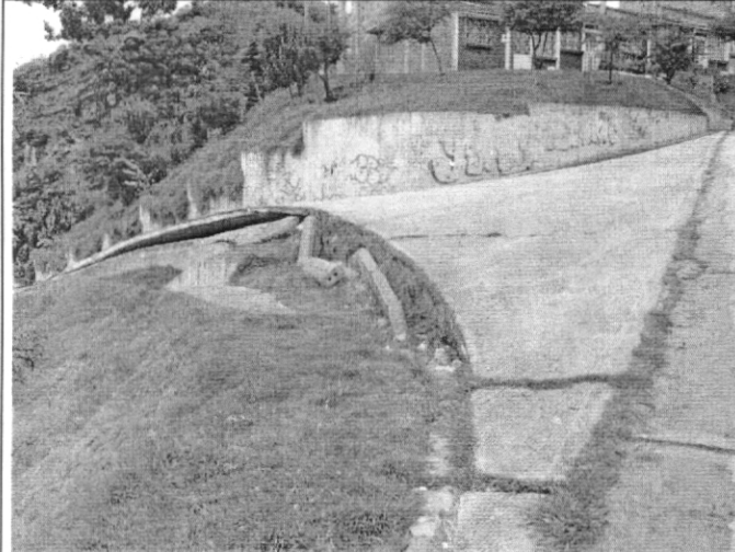
Foto 5. Placas en voladizo a la altura de la Calle 3 Bis con Transversal 8 Este.
