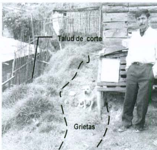
Fotografía 2. Grietas en suelo de la parte frontal de la vivienda de Luis Alfonso Medina debidas a la inestabilidad del talud de corte.
