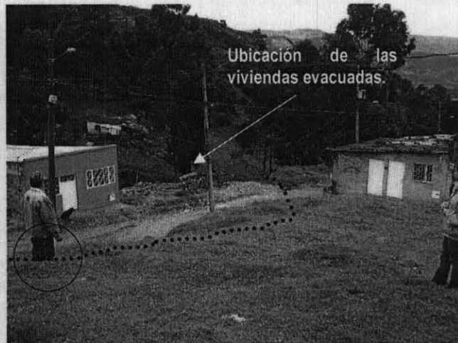
Fotografía 6. Emplazamiento de las viviendas desalojadas y de la vivienda de Sra. Rosa Tulia, nótese la altura del escarpe, las líneas punteadas indican el límite de la masa deslizada.
