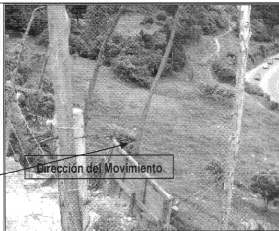
Foto 4. Vista del coluvión inestable, en la que se aprecian las evidencias del reptamiento que está sufriendo la ladera.
