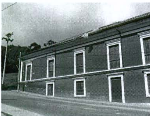
Fotografía No. 1. Vista costado norte del edificio afectado (Fachada Occidental).
