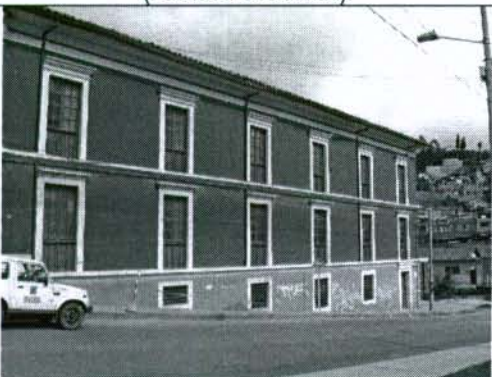
Fotografía No. 3. Vista costado sur de la fachada del edificio afectado (Fachada Occidental).
