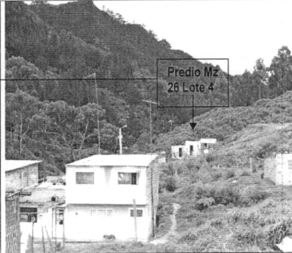
Foto 4. Panorámica de la ladera que presenta procesos de reptación y localización del predio de la Manzana 26 Lote 4.
