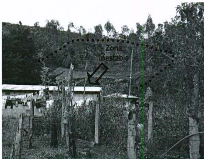
Fotografía 4. Zona en la que se presenta el deslizamiento complejo, la flecha indica la dirección del movimiento. Nótese la ubicación de la vivienda.
