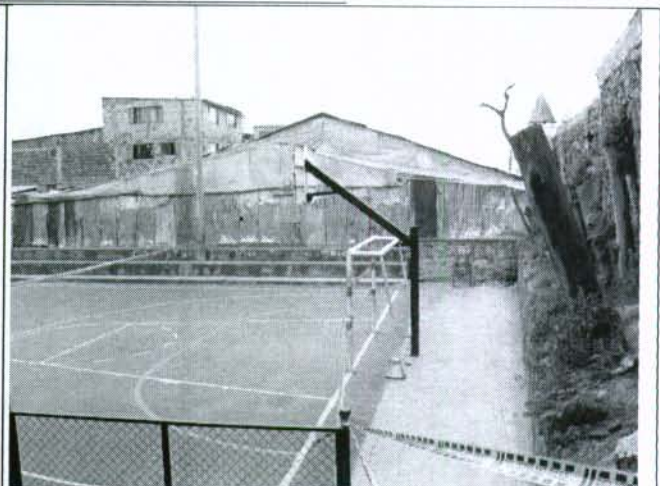
Foto 4. Se realizó el cerramiento preventivo con cinta de balizaje del sector de la cancha deportiva que colinda con el muro.
