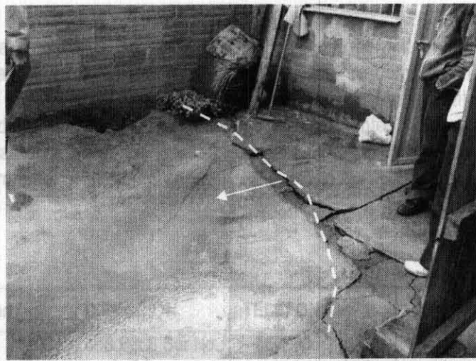
Foto No.2 Hundimientos en el patio de la vivienda con nomenclatura Calle 48B Bis B Sur # 9 - 24, que marcan la dirección de los desprendimientos descritos
