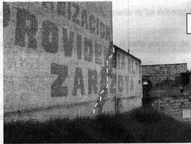
Foto No.3 Agrietamientos en la parte posterior de la vivienda con nomenclatura Calle 48B Bis B Sur # 9 - 24, ubicada en la parte alta de un talud con suelo arcilloso.
