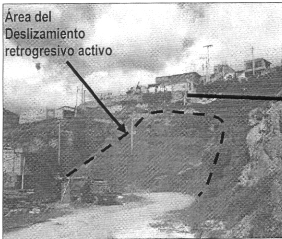
Fotografía 3 Deslizamiento en la parte baja de la vivienda de la Sra. Ana C. Galindo.
