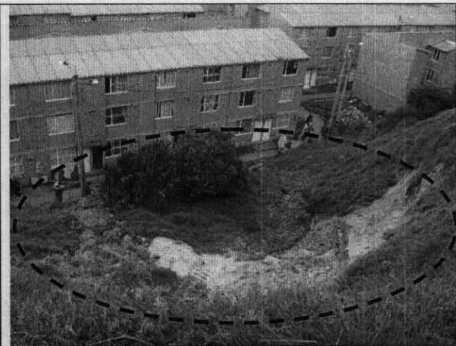
Fotografía 4. Vista del deslizamiento, desde la parte alta de la ladera.
