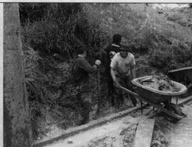
Fotografía 4. Labores de excavación para colocar el muro en gaviones.
