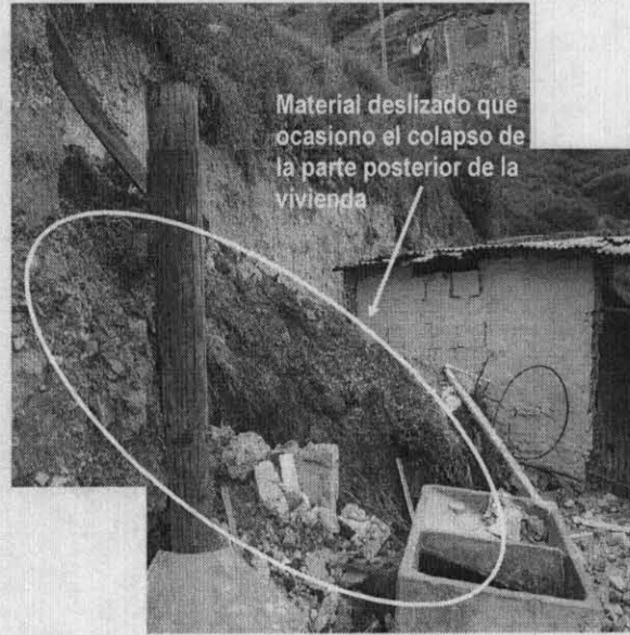
Fotografía 6 Parte posterior de la vivienda de la Sra. Marlene Garzón.
