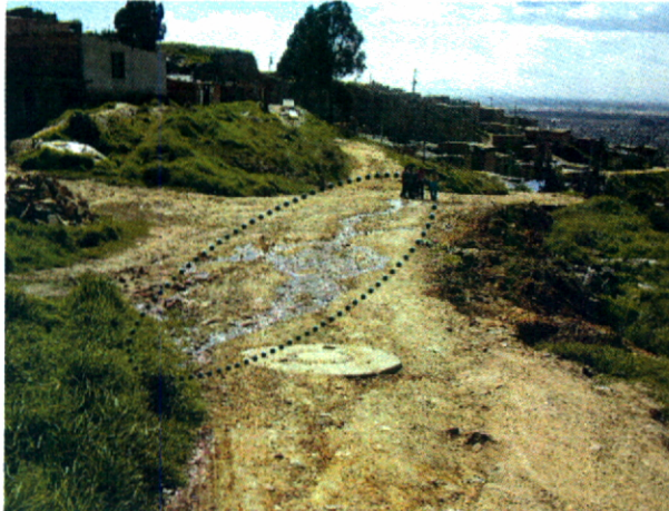
Fotografía 4. Zona I, fugas de la red de alcantarillado que se infiltran en la masa deslizada, también se aprecian escombros depositados en la cabeza del deslizamiento.
