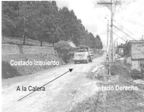
Fotografía 3 Antigua vía a la Calera Se observa la falta de obras de drenaje para el manejo de las aguas de escorrentía. Adicionalmente se muestra parte del tráfico que transita la vía.
