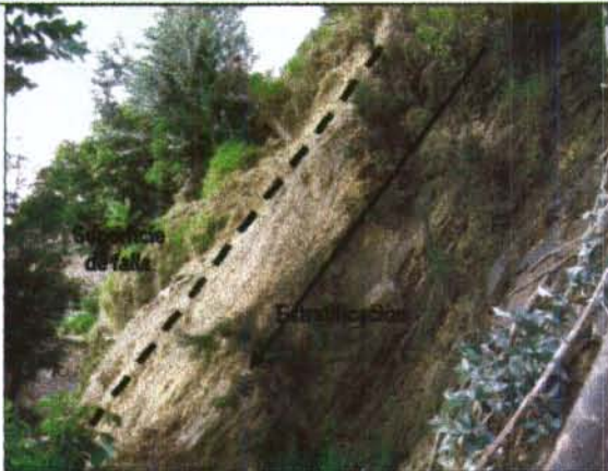
Foto 1. Aspecto de la parte baja y media del talud. Se muestra la superficie de deslizamiento y la estratificación del macizo rocoso. Formación Cacho.
