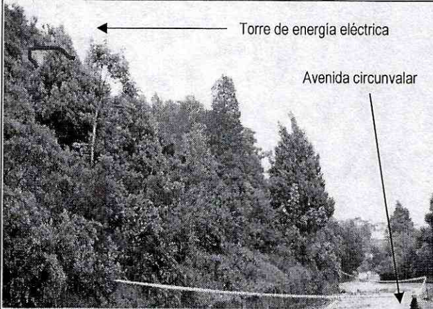
Foto 1. Proceso de inestabilidad, la masa deslizada se dispuso sobre el carril derecho sentido sur-norte de la Avenida Circunvalar, se aprecia el aislamiento realizado con cinta de valizaje.
