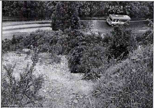
Foto 2. El deslizamiento alcanzó a afectar el tránsito normal de los vehículos que transitan por la Avenida Circunvalar
