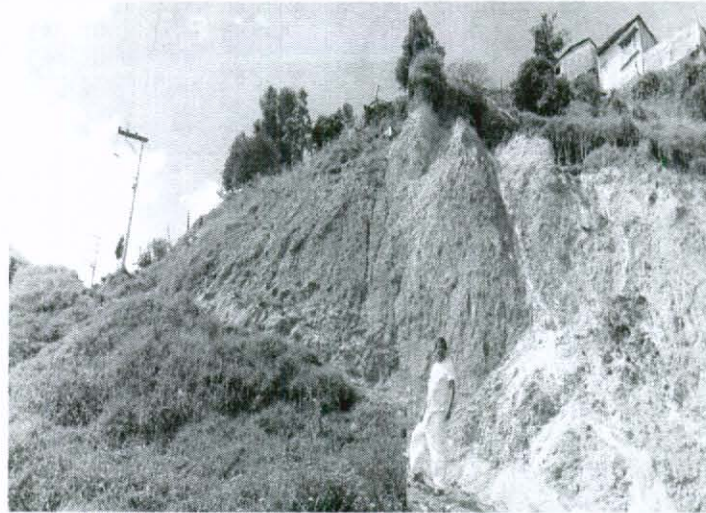
Foto 6 Talud de la parte superior de la vía – Deslizamiento antiguo
