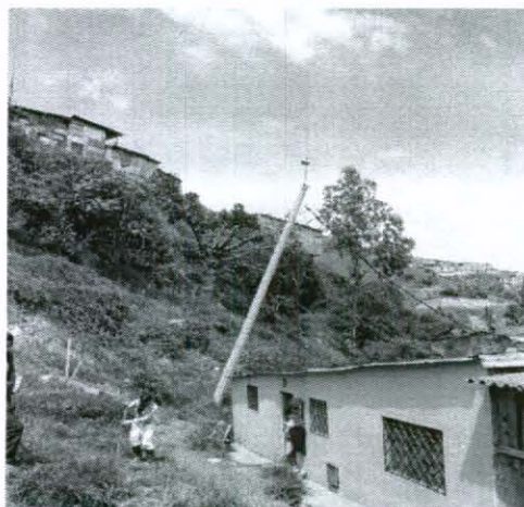
Foto 7 – Poste de alumbrado público por caer en la vivienda.
