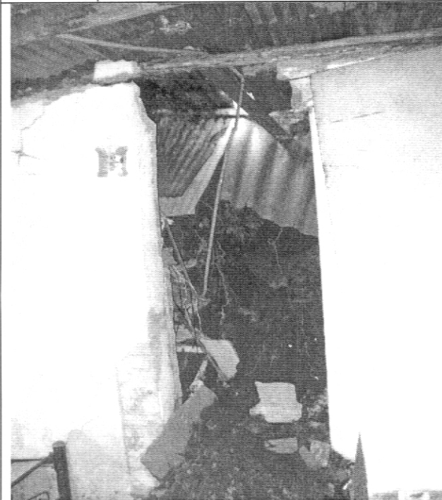
Foto 1. Se aprecia el hundimiento de los materiales en el mismo sentido de la pendiente del terreno.
