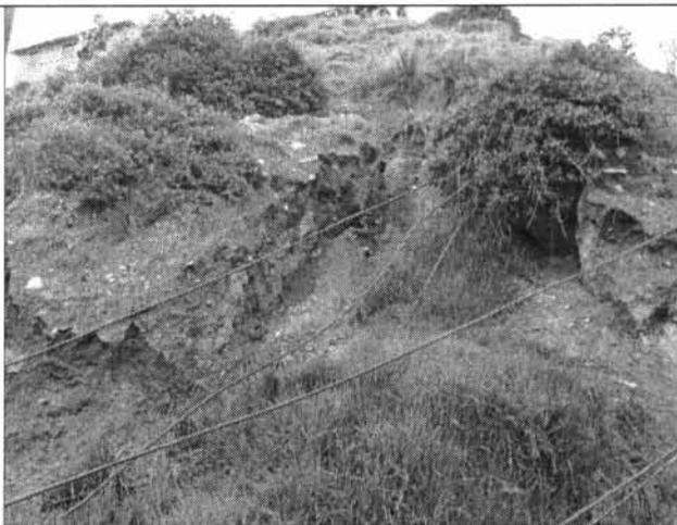
Foto 6. Talud localizado hacia el costado occidental del sitio del evento, se aprecian evidencias de inestabilidad.
