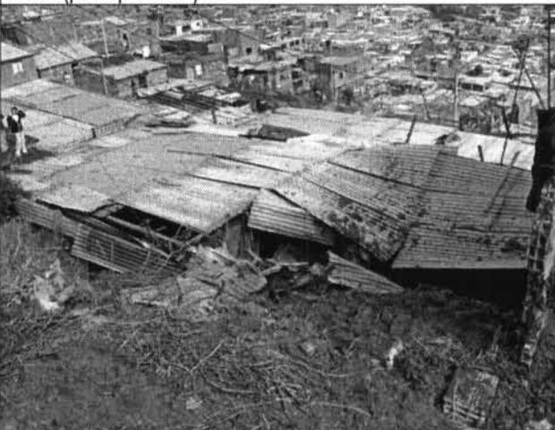
Foto 4. Predio de calle 77 sur # 74 G - 06, afectado por el material depositado por el flujo de tierras.
