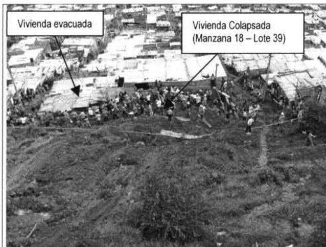
Foto 1. Vivienda colapsada (Manzana 18 - Lote 39) por el empuje del material deslizado en el flujo de tierras
