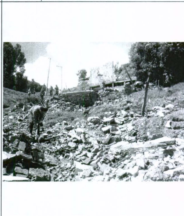
Foto 4. Vivienda ubicada en frente del predio de la diagonal 25 sur # 16 C este - 14, proceso de inestabilidad que afectó la vivienda con pérdida de suelo de cimentación.
