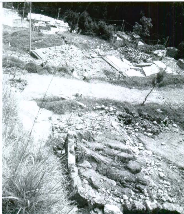
Foto 5. Agrietamientos en pisos del predio de la diagonal 25 sur # 16 C este - 14, comprometiendo su estabilidad y habitabilidad en el corto plazo.
