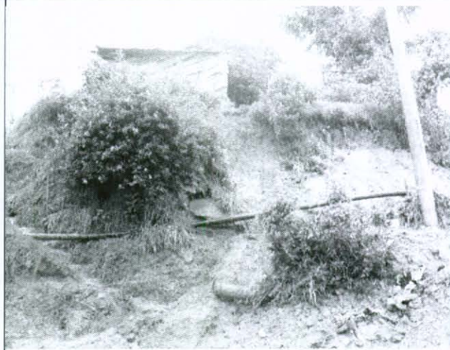
Foto 4. Vivienda ubicada en frente del predio de la diagonal 25 sur # 16 C este - 14, proceso de inestabilidad que afectó la vivienda con pérdida de suelo de cimentación.
