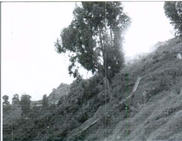
Foto 6. Parte media y baja de la ladera donde se presentan procesos de reptación evidenciados en la pérdida de verticalidad de los árboles y agrietamientos en el terreno.
