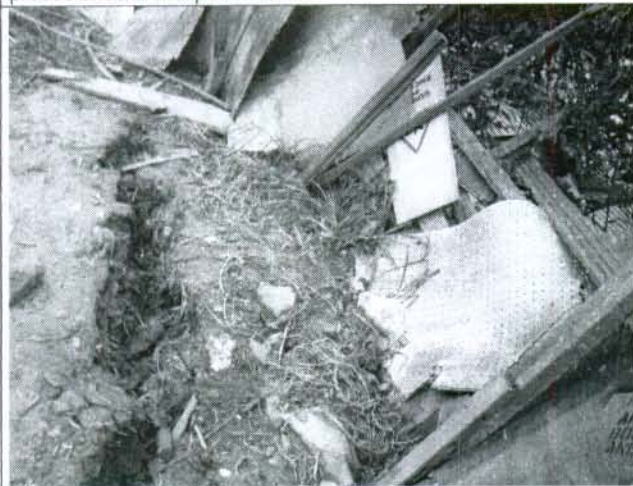
Foto 1. Falla de un talud sobre la parte posterior del predio, produciendo el colapso de este.
