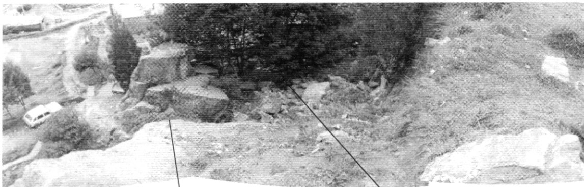
Fotografía 2. Se observa la parte inferior del escarpe de la antigua explotación minera localizado entre las Carreras 22 D y Carrera 23 A, a la altura de la Calle 185 A Bis, lugar donde se presentaron las caídas de bloques y pequeños flujos de detritos.
