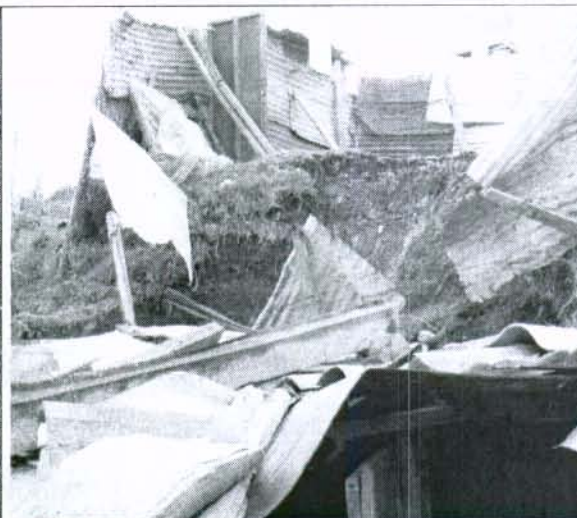
Foto 2. Detalle de las afectaciones en la parte posterior del predio del Señor Henry López.
