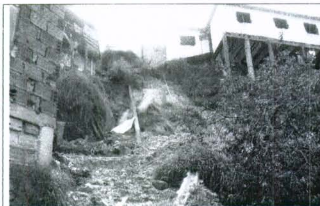
Foto 3. Las lluvias presentadas durante los últimos días desencadenaron la ocurrencia de fenómenos de remoción en masa, afectando gran cantidad de viviendas.
