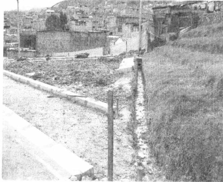
Construcción Filtro de Drenaje – Zona Nor -occidental de la Cancha Múltiple. Fotografía No. 1
