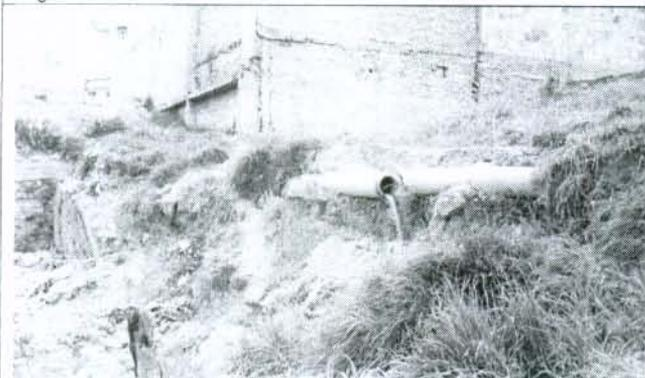
Foto 3. Los propietarios de la vivienda rompieron los tubos del alcantarillado para poder controlar los vertimientos de aguas residuales.
