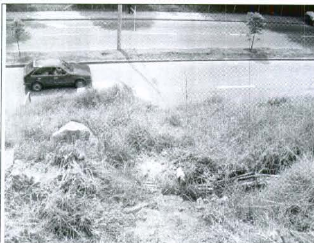
Foto 5. Sobre la avenida circunvalar existe un alto flujo de vehículos, que se encuentran en riesgo por caída de rocas o reactivación del proceso de inestabilidad
