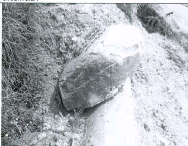
Foto 2. Presencia de bloques de arenisca con diámetros de hasta 1 metro, que amenazan con caer sobre la avenida circunvalar.
