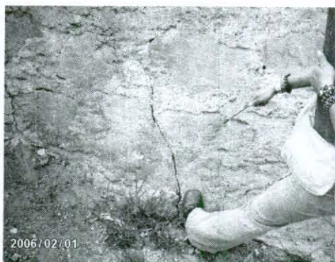
Foto No. 4 Grietas en muro y cimentación.
