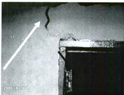
Foto No. 4 Grietas en muro y cimentación.
