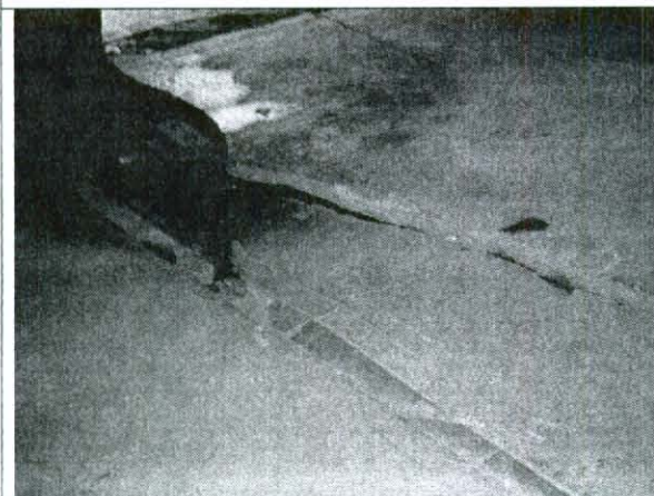
Foto 3. Levantamiento de la losa de contrapiso en el sótano sector Sur Oriental de 0.15m aproximadamente.
