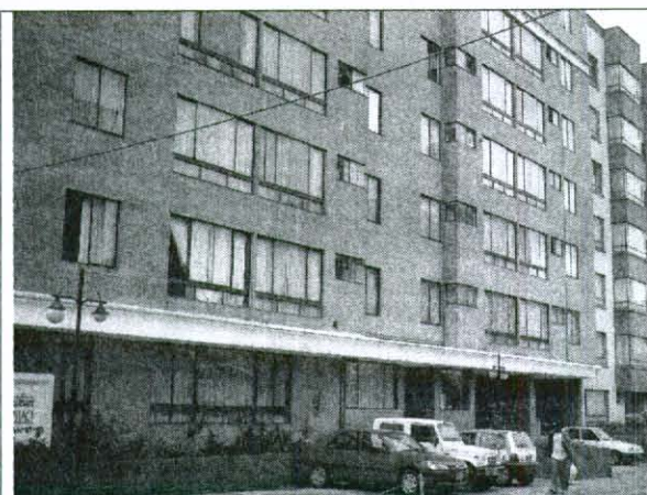
Foto 1. Fachada sobre la Calle 146 A (Hoy Calle 150 A).
