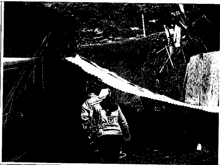
Foto 2. Aspecto de una de las viviendas evacuadas.
