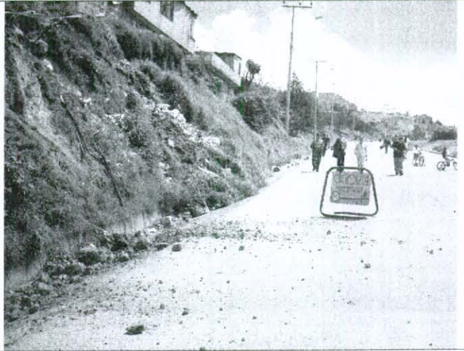
Foto No. 6. Vista lateral del talud vial, donde se aprecian los materiales desprendidos y acumulados en la cuneta de la calzada Oriental de la Avenida Boyacá.
