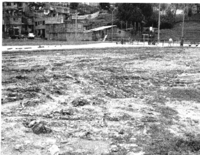
Foto 7. Aumento en los encharcamientos debido a las obras del parque
